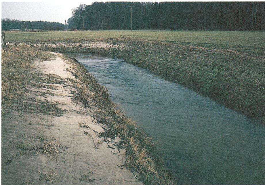
Foto 25: Zur Verringerung der Sandführung wurden mehrere Sandfänge angelegt — hier im Unterlauf des Remseder Baches
