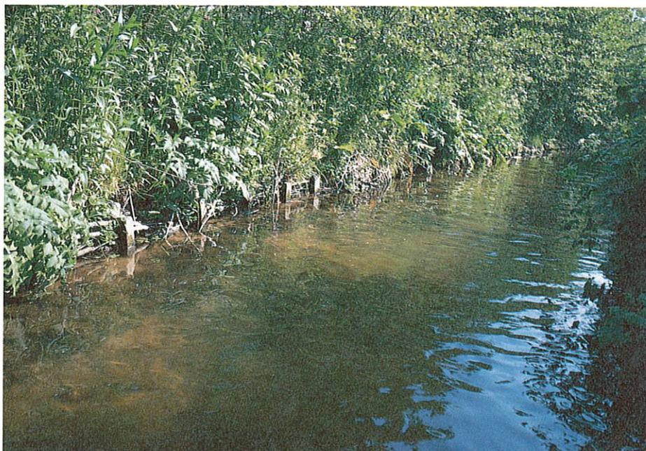
Foto 14: Auch die auf Teilstrecken eingebauten Rohrbäume — hier im Mai 1988 — sind inzwischen in der Ufersicherung durch die Ufervegetation abgelöst worden
