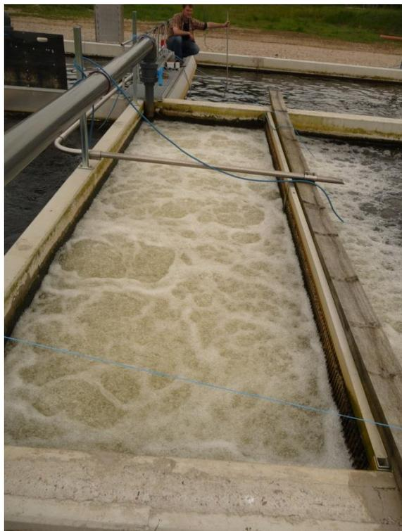
Abb. 8: HP-Förderer vor dem Mastbecken 1 mit dahinter liegender feinblasiger Sauerstoffausströmung
