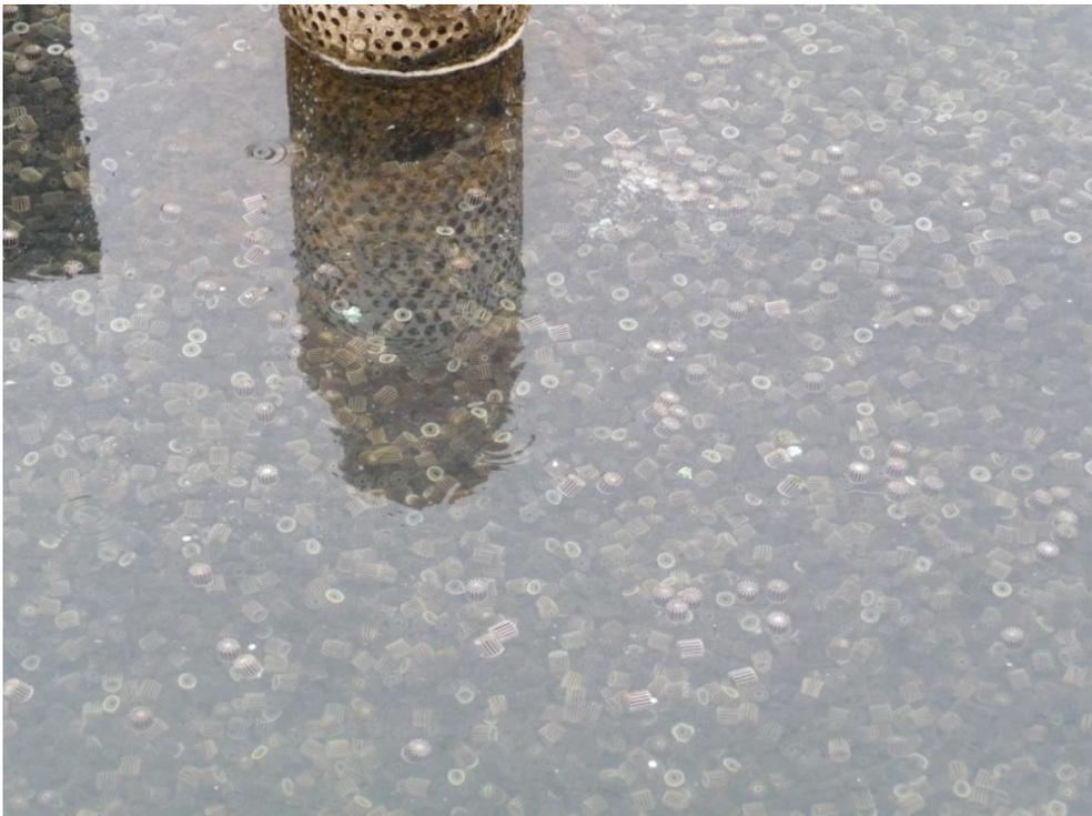
Abb. 5: Füllkörperbett der gefluteten Stationärtropfkörper in der Satzfishanlage
