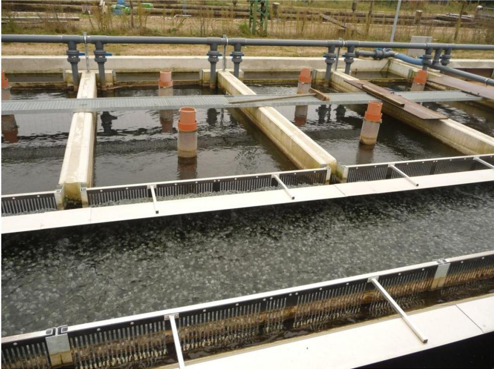
Abb. 4: Biofilter der Satzfishanlage (vorn: moving bed-Filter, dahinter gefluteter Stationärtropfkörper)
