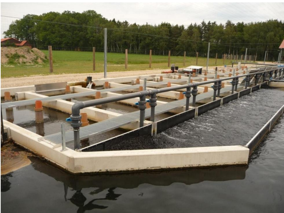
Abb. 10: Biofilter der Mastanlage von der Zuflusseite (vorn: moving bed-Filter, dahinter gefluteter Stationärtropfkörper)
