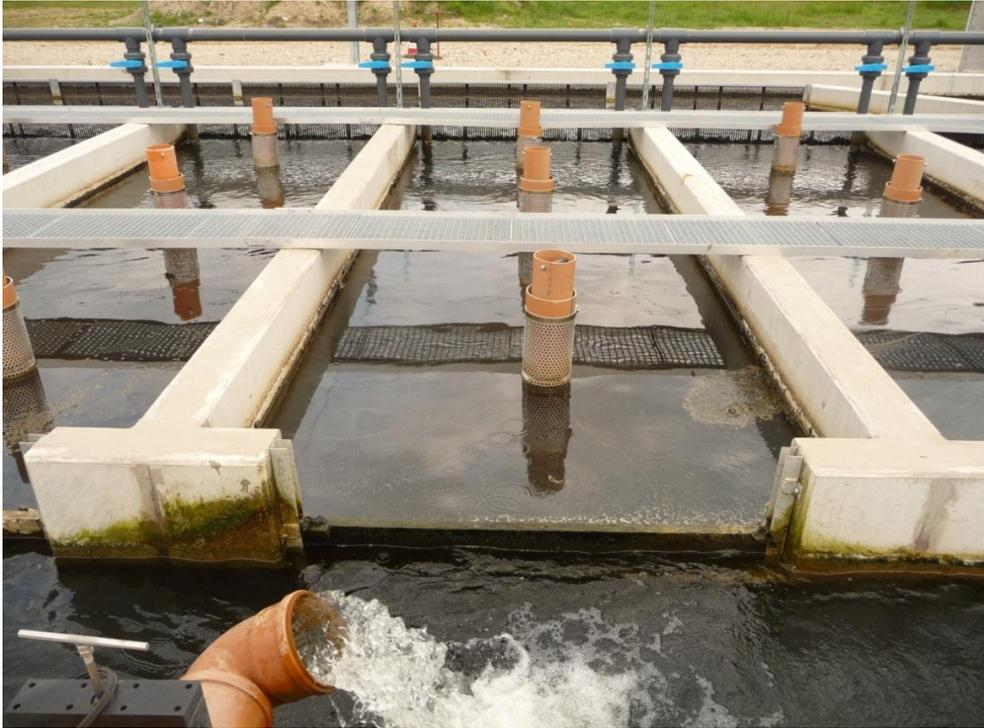
Abb. 11: Biofilter der Mastanlage von der Abflusseite (vorn: gefluteter Stationärtropfkörper und Frischwasserzufuhr)
