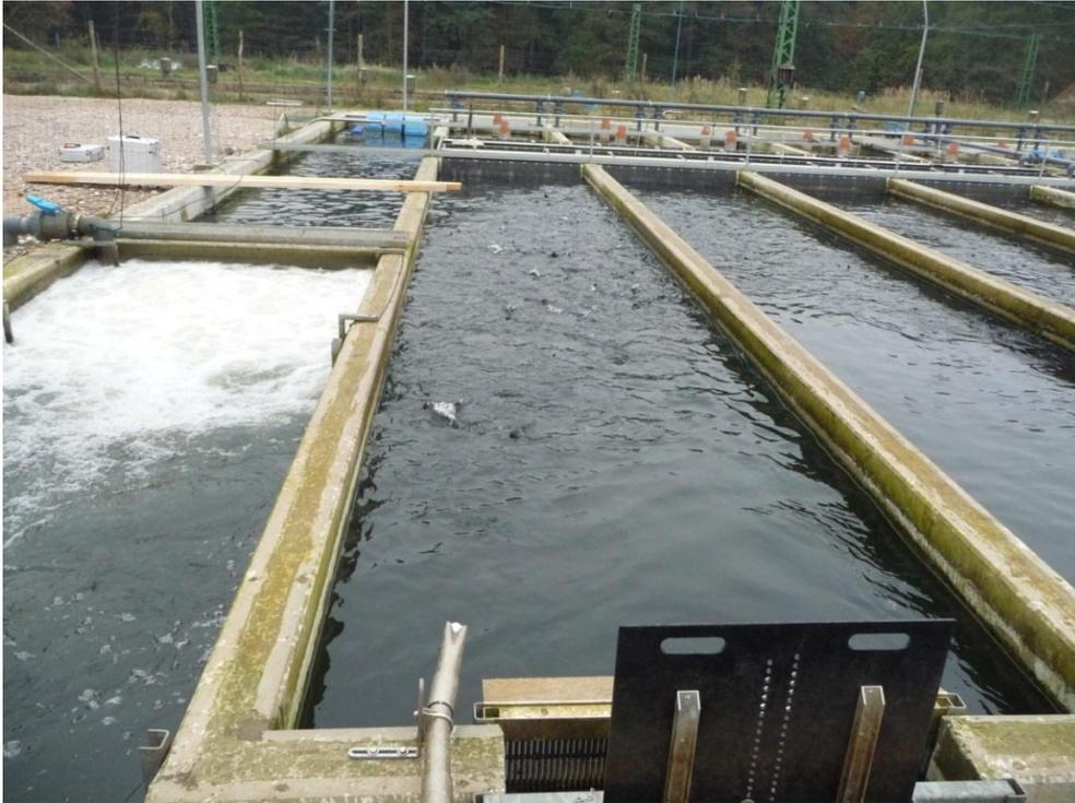
Abb. 2: Satzfishanlage von vorn in Flussrichtung (rechts: Fischhaltungsbecken, dahinter Biofilter, links: Rückführungskanal mit schwimmendem O<sub>2</sub>-Niederdruckbegaser und HP-Förderer)
