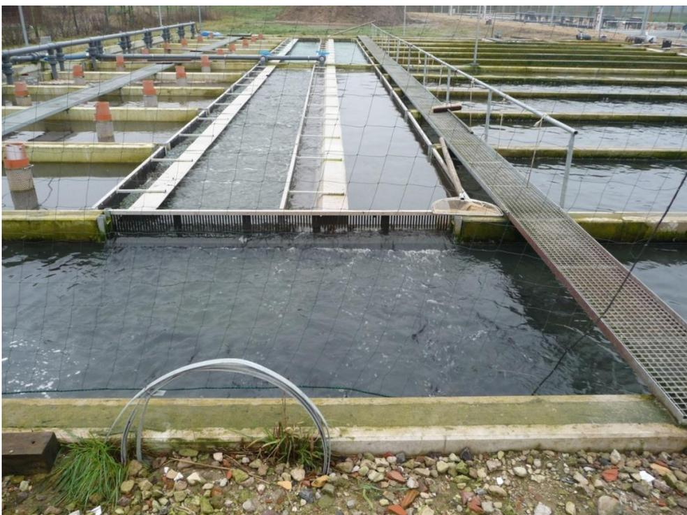
Abb. 3: Satzfishanlage von der Seite (rechts: Fischhaltungsbecken, Mitte: moving bed-Filter, links: gefluteter Stationärtropfkörper, vorn: Rückführungskanal)
