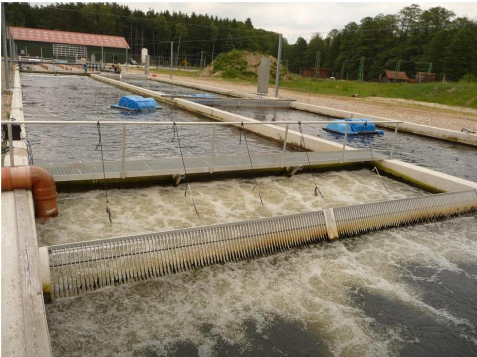
Abb. 9: Mittelblasige Ausströmung zur CO<sub>2</sub>-Entgasung vor dem Becken 2 der Mastanlage
