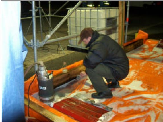
**Abbildung 41: Abpumpen der Verbrauchslösung.**
