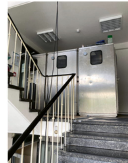
Zugangsschleuse zum Flur im Heckenweg 4 (Foto links) und Staubschutzwand zur Isolierung des ICP-MS-Labors (Foto rechts)
