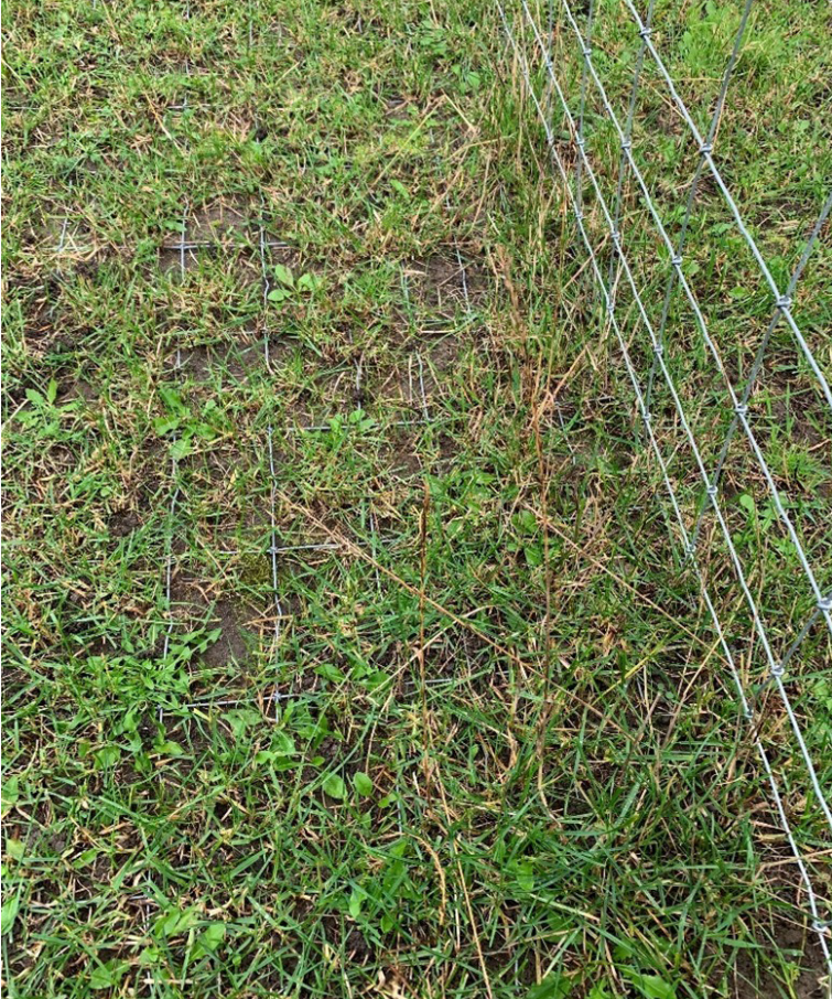
Untergrabungsschutz durch eine Schürze aus Maschendraht, Demozaunanlage der LWK Niedersachsen im LBZ Echem
