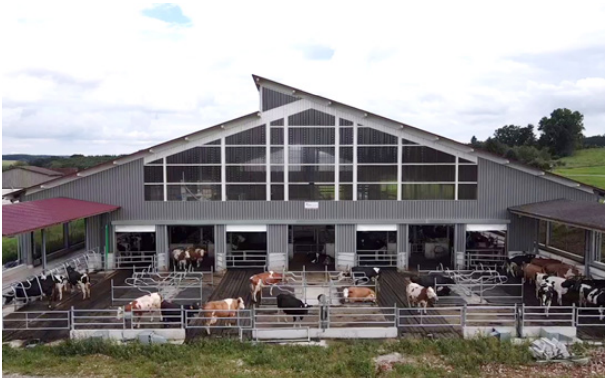
Die Futterachsen werden bei diesem 6-reihigen Laufstall des EIP Rind Betriebes Bunz bis in den Laufhof gezogen und die Entmistungsachsen fortgeführt. Dadurch verbleiben wenige Quadratmeter auf den Quergängen des Laufhofes für die manuelle Entmistung. Die Tiere können nun alle Verhaltensweisen aus dem Stall auch draußen ausüben.
