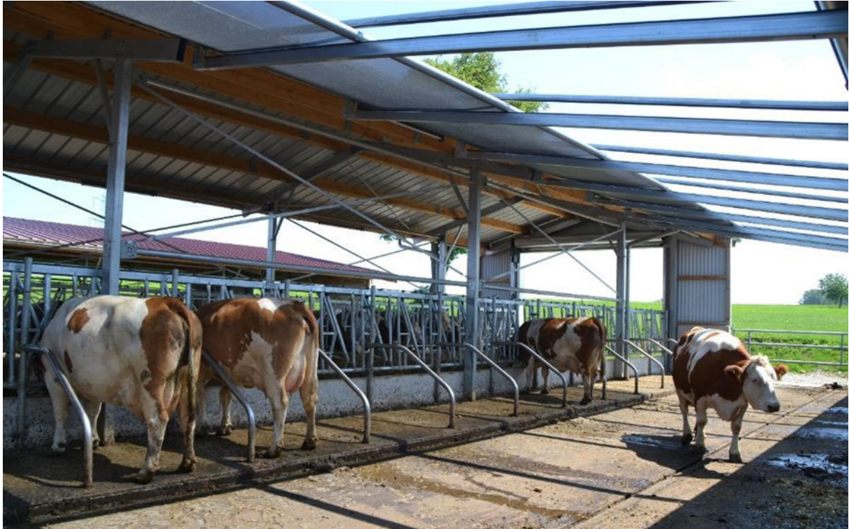
Erhöhte Fressstände reduzieren die emittierende Fläche im EIP Rind Betrieb Stier um 14% und die planbefestigten Laufflächen mit 3% Quergefälle ermöglichen einen raschen Harnabfluss
