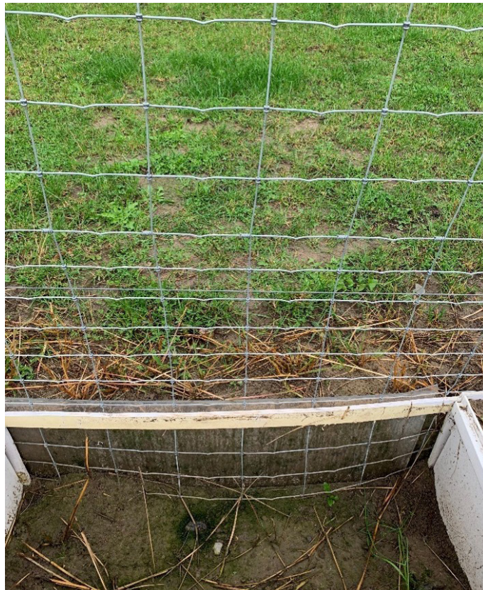
Untergrabungsschutz durch senkrecht eingegrabenen Maschendraht, Demozaunanlage der LWK Niedersachsen im LBZ Echem
