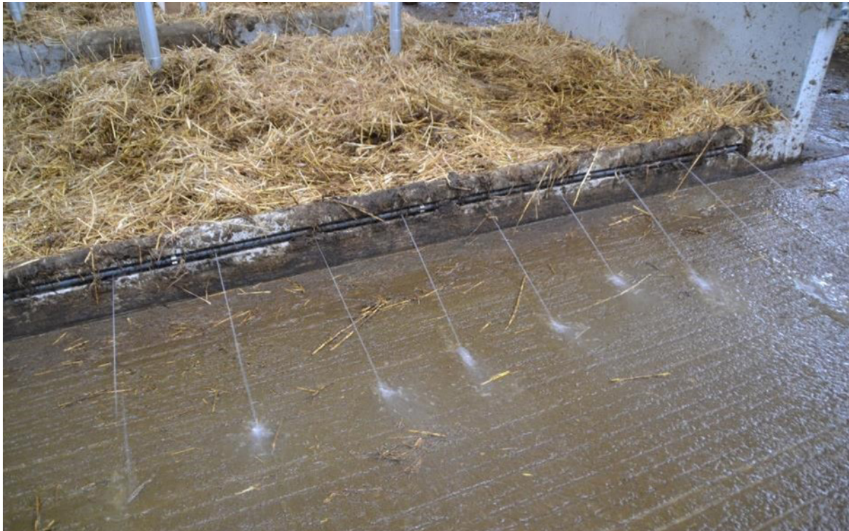
Eine integrierte Befeuchtungseinrichtung kann im EIP Rind Betrieb Hammer dazu beitragen, Schmierschichten zu verringern und die Laufganghygiene verbessern, während das NH 3 -Emissionspotenzial verringert wird
