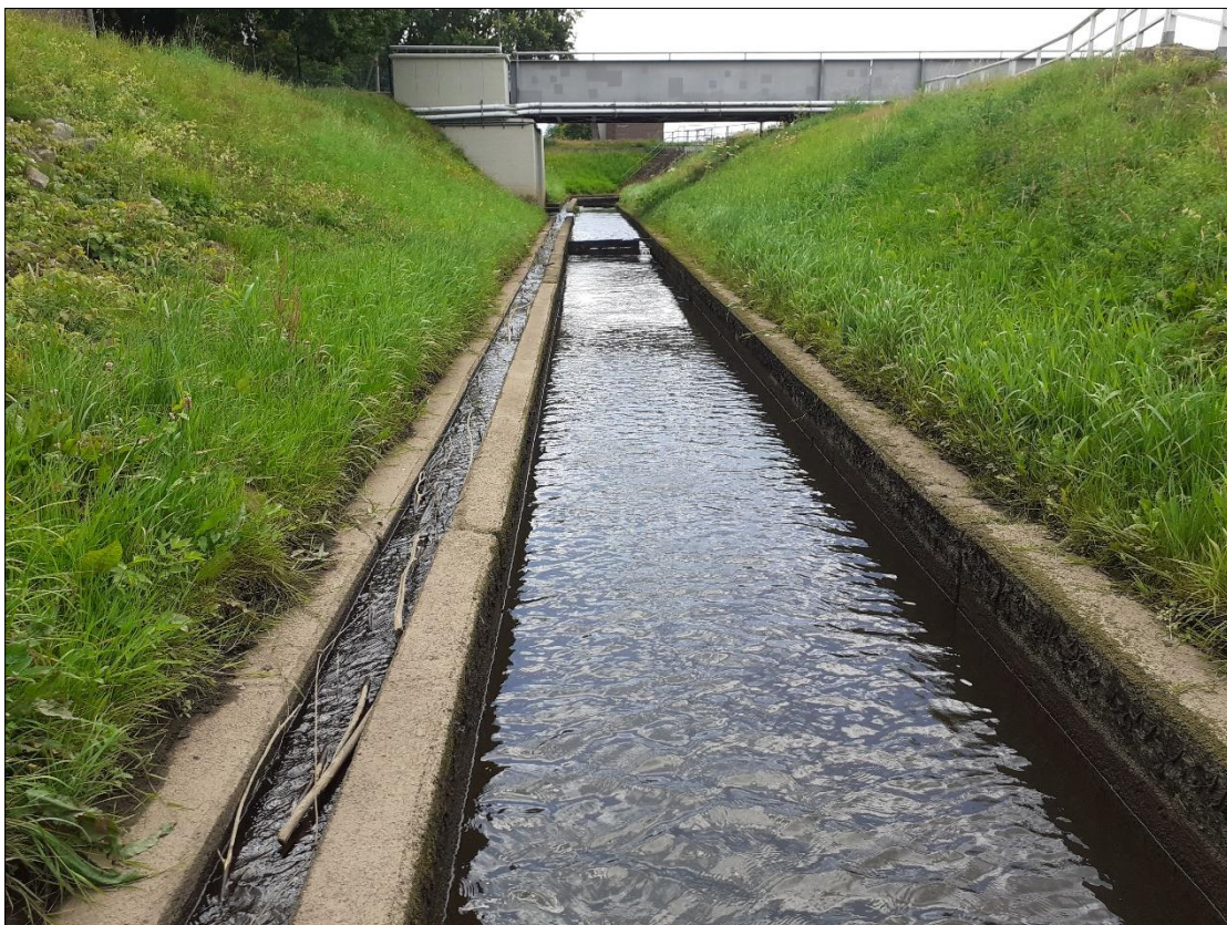
Abbildung 4: Blick auf die FAA mitsamt Aalfangrinne (Foto: Landesfischereiverband Weser-Ems e.V.),
