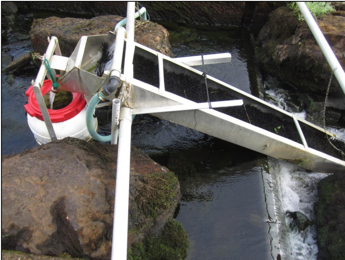
Abbildung 7: Aalleiter in der FAA Bollingerfähr (Foto: LAVES).
