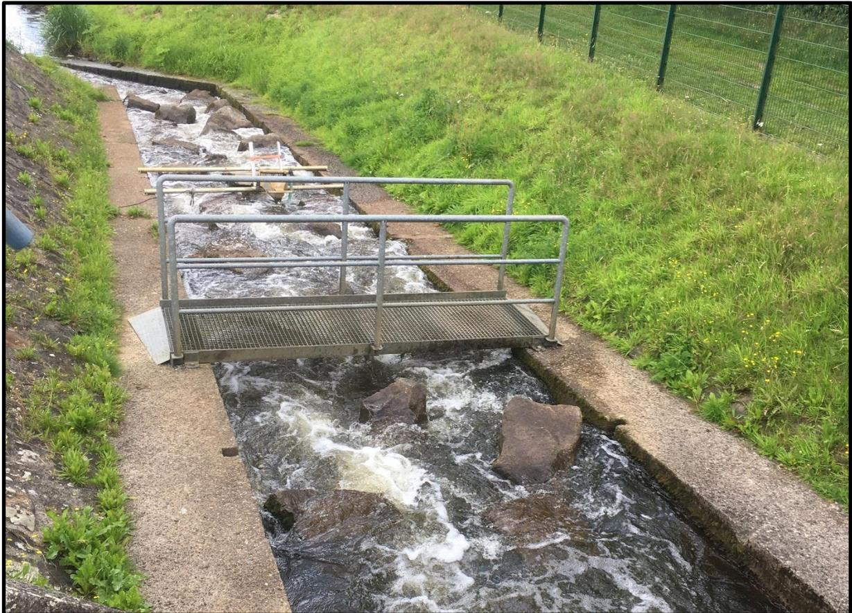
Abbildung 4: Beckenpass mit Aalleiter (im Hintergrund) am Stauwehr Bollingerfähr (Quelle: Landesfischereiverband Weser-Ems).
