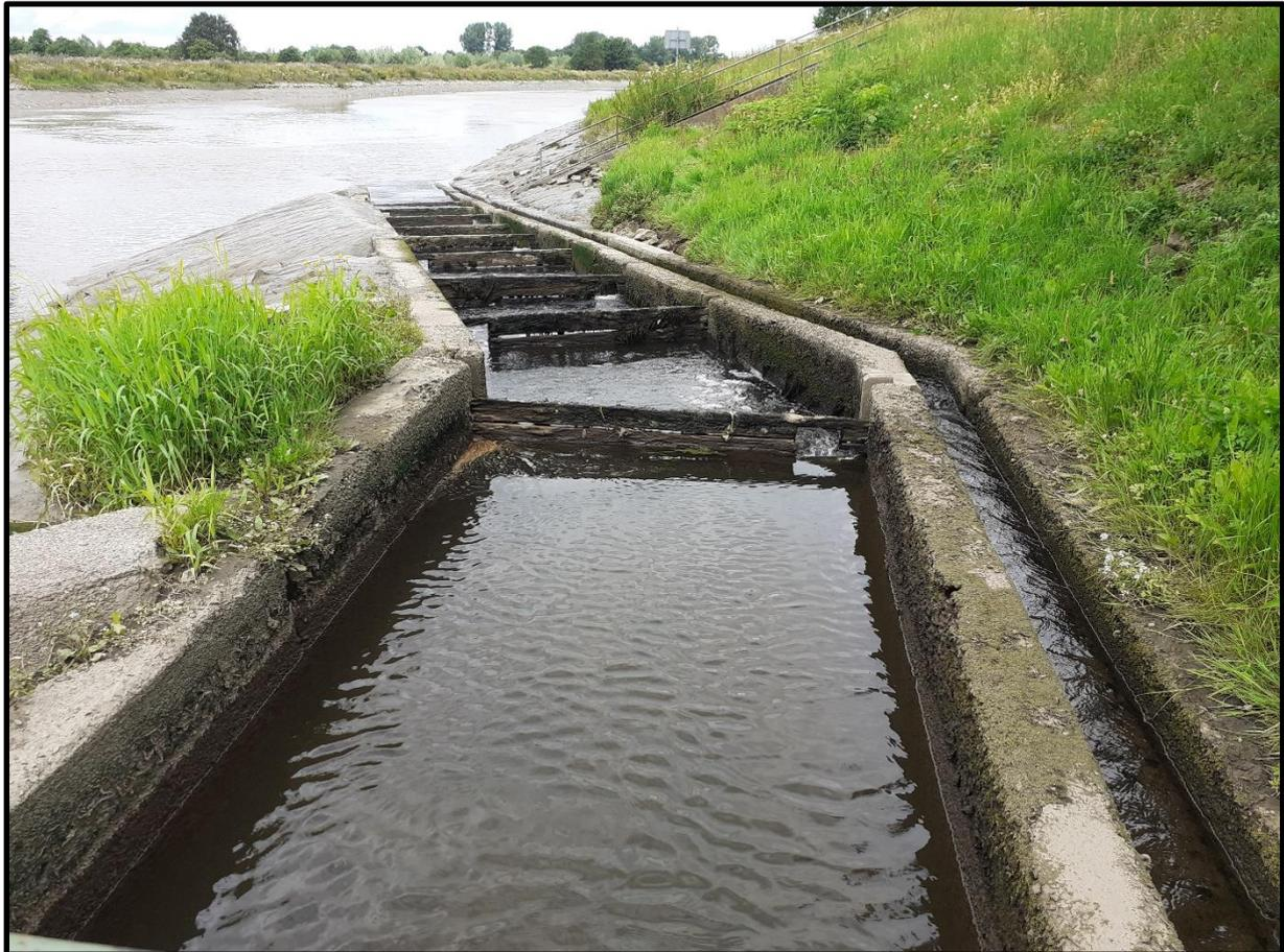
Abbildung 3: Blick flussabwärts auf die Fischaufstiegsanlage am Tidewehr Herbrum und die parallel dazu verlaufende Aalfangrinne bei Niedrigwasser (Quelle: Landesfischereiverband Weser-Ems).
