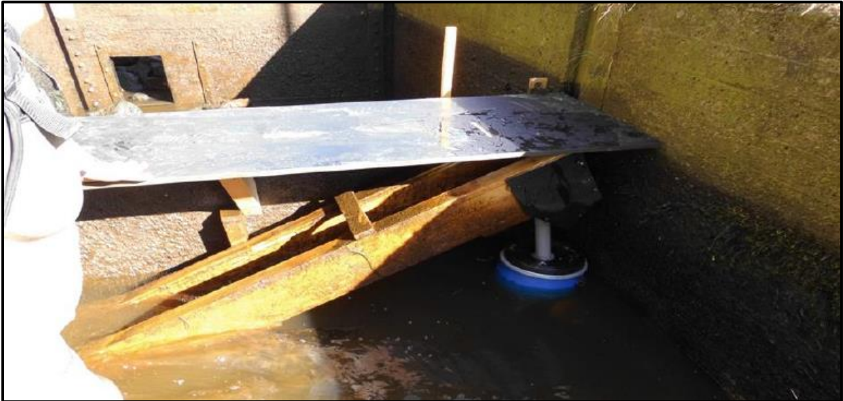
Abbildung 4: Lage der Aalleiter, des Auffangbehälters sowie der Überlaufplatte (Quelle: Landesfischereiverband Weser-Ems).
