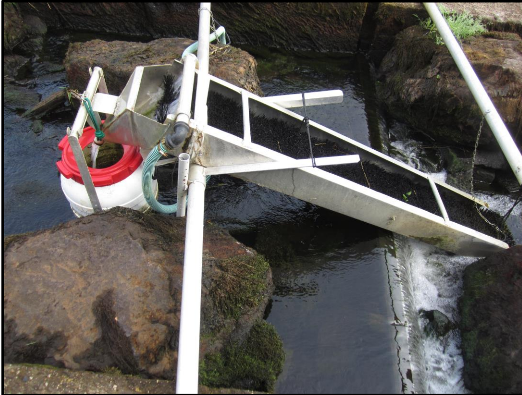
Abbildung 3: Aalleiter in der FAA am Stauwehr Bollingerfähr (Quelle: LAVES).
