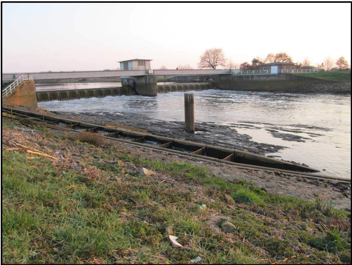
Abbildung 2: Blick auf das Tidewehr bei Niedrigwasser sowie auf die Fischaufstiegsanlage mit der parallel dazu verlaufenden Aalfangrinne im Vordergrund (Quelle: Landesfischereiverband Weser-Ems).
