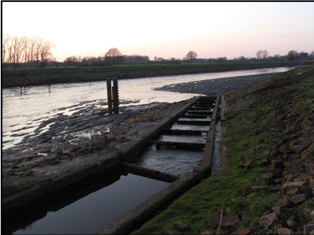
Abbildung 2: Blick flussabwärts auf die Fischaufstiegsanlage am Tidewehr Herbrum und die parallel dazu verlaufende Aalfangrinne (rechts) bei Niedrigwasser (Quelle: Landesfischereiverband Weser–Ems).
