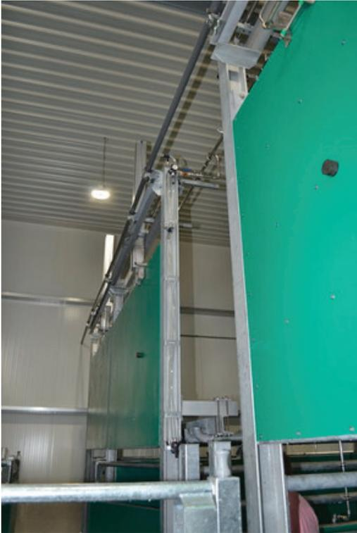
Foto 2: Hubtore, die die Buchten voneinander abtrennen und eine leichte Bedienung beim Separieren der Abladegruppen möglich machen
