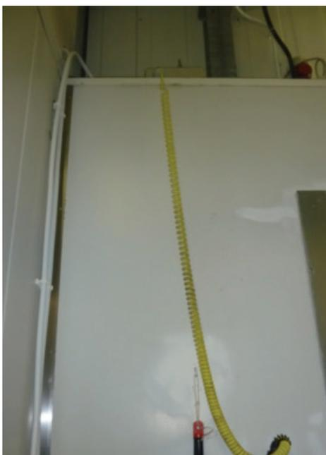
Elektrobetäubung: Anzeigen für Anwender nicht einsehbar
