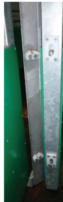
Foto 3: Kunststofflager sorgen für ein geräuscharmes Öffnen und Schließen von Türen und Toren.
