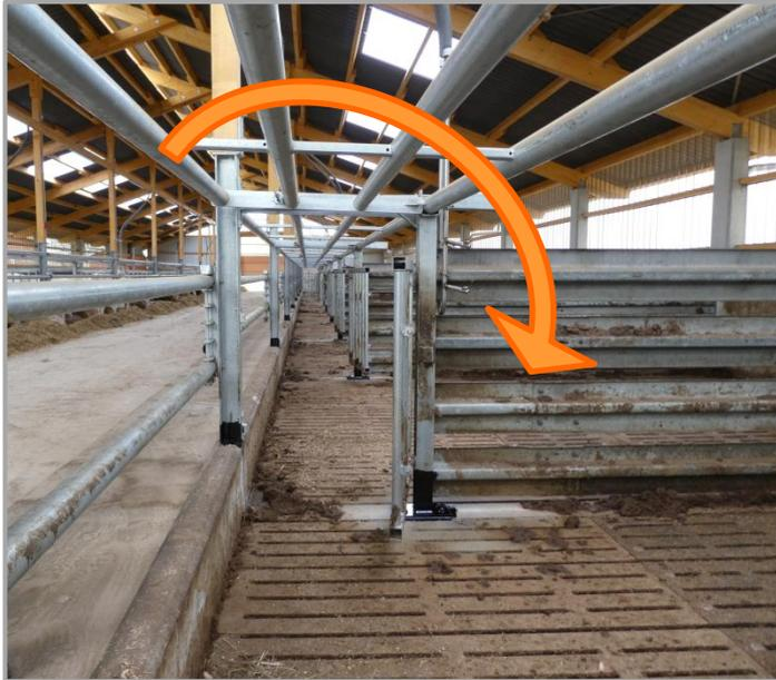
Abb. 10: Beispiel eines in die Bucht integrierten Treibganges, der durch Runterschwenken des oberen Gitters (s. Pfeil) an der Futtertischseite entsteht (Foto: Tierschutzdienst).
