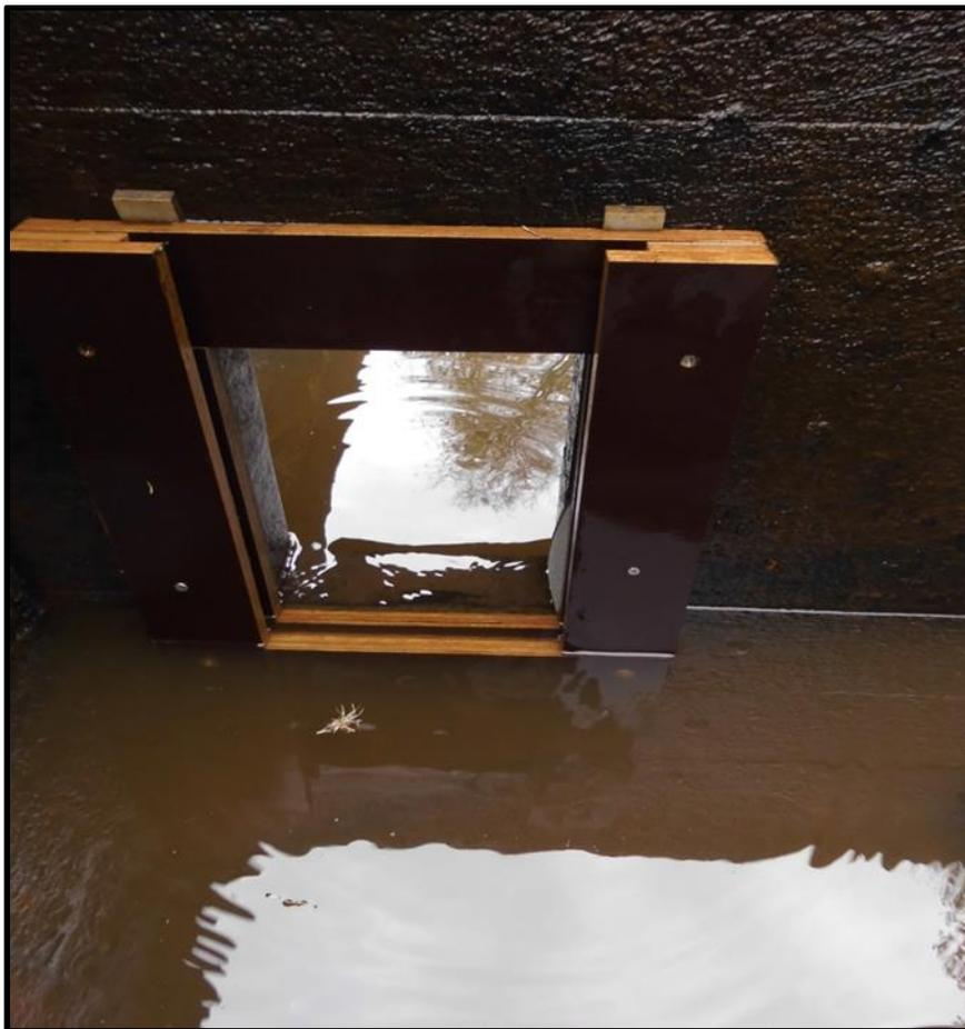
Abbildung 7: Installierter Schieber im Durchlass einer Trennwand der Fischaufstiegsanlage (Quelle: Landesfischereiverband Weser-Ems).
