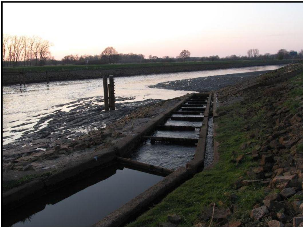
Abbildung 2: Blick flussabwärts auf die Fischaufstiegsanlage am Tidewehr Herbrum und die parallel dazu verlaufende Aalfangrinne bei Niedrigwasser (Quelle: Landesfischereiverband Weser-Ems).
