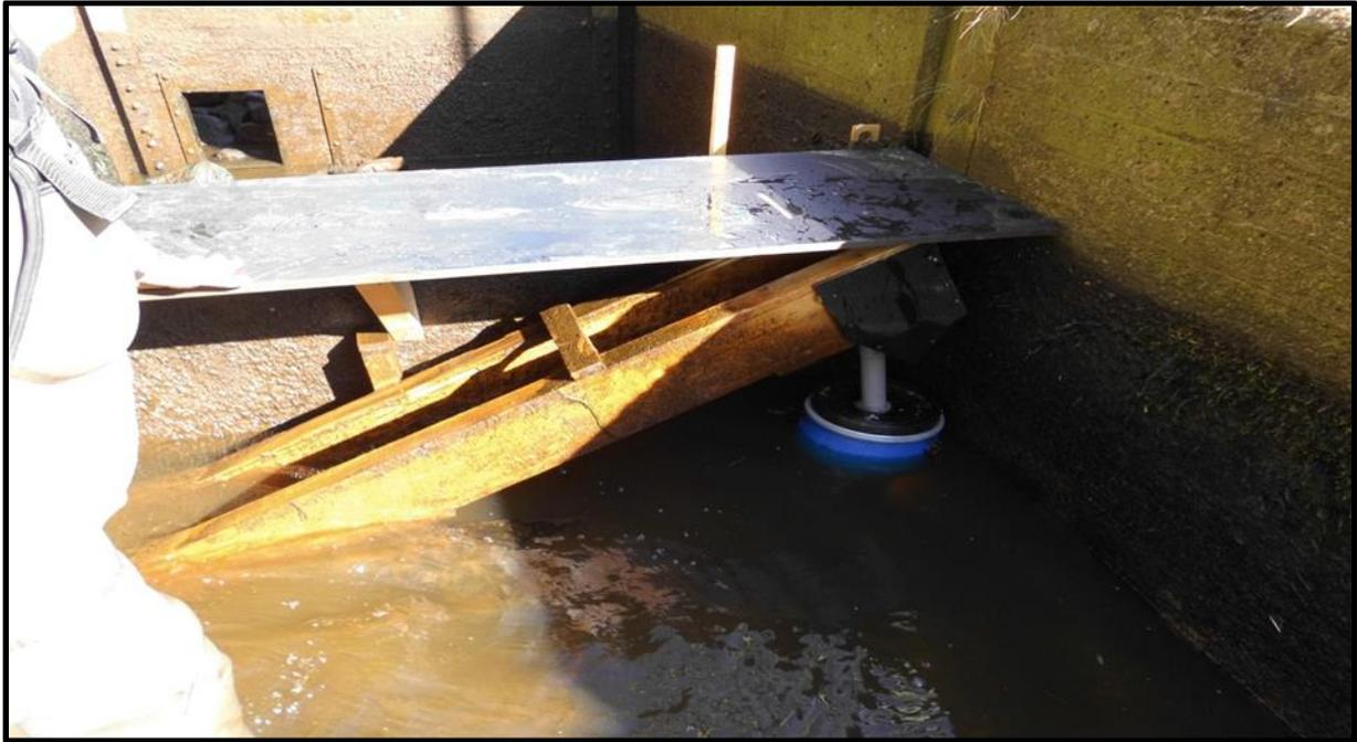
Abbildung 8: Lage der Aalleiter, des Auffangbehälters sowie der Überlaufplatte (Quelle: Landesfischereiverband Weser-Ems).
