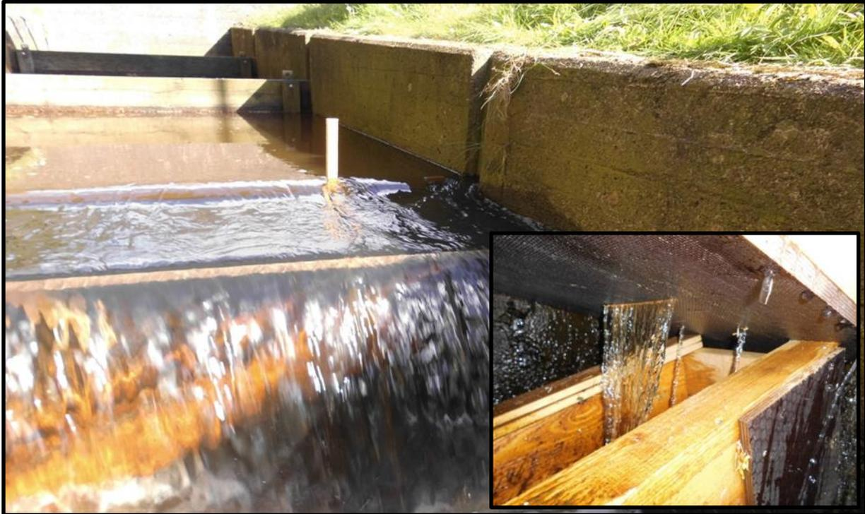
Abbildung 9: Aalleiter in Betrieb. Kleines Bild: Funktionsprinzip der Wasserdotation (Quelle: Landesfischereiverband Weser-Ems).
