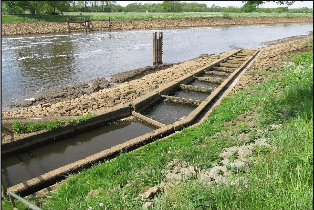
Abbildung 10: FAA und Aalfangrinne am Tidewehr Herbrum am 11.05.2016. 2016 waren im Vergleich zum Vorjahr deutlich weniger Schlickablagerungen im unteren Bereich der FAA zu verzeichnen (Quelle: Zaudtke, Landesfischereiverband Weser-Ems).
