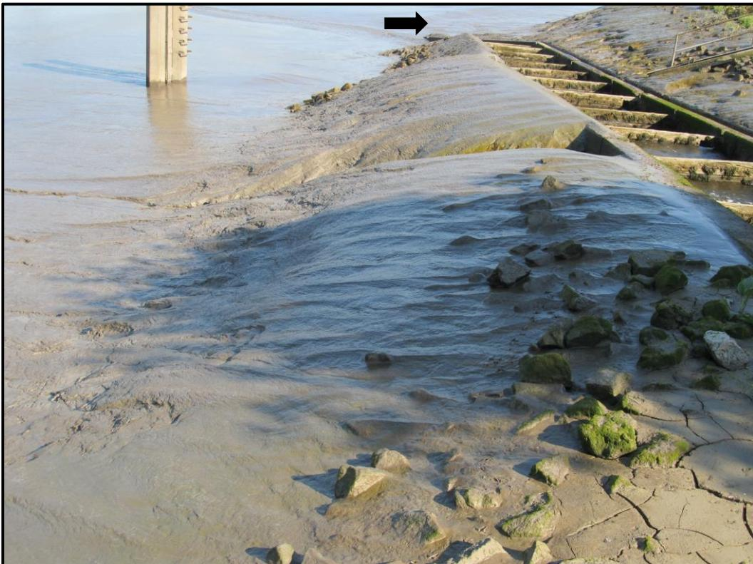
Abbildung 22: FAA und Aalfangrinne am Tidewehr Herbrum bei Niedrigwasser am 19. Juli 2015. Deutlich zu erkennen sind die massiven Schlickablagerungen vor dem Auslauf in die FAA und die Aalfangrinne (Pfeil) sowie am Ufer (Quelle: Landesfischereiverband Weser-Ems).
