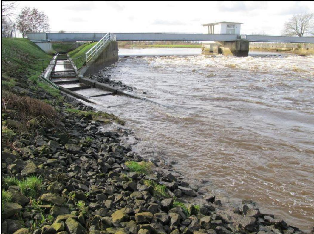
Abbildung 12: Tidewehr Herbrum bei Hochwasser, Blick von Unterwasser. Das Bild zeigt den niedrigsten Wasserstand am 3. April 2015 um 10:29 Uhr, eine Viertelstunde später waren die FAA und die Aalfangrinne wieder überstaut. Infolge von Hochwasser konnte Anfang April keine Untersuchung zum Aalaufstieg am Tidewehr Herbrum erfolgen (Quelle: Landesfischereiverband Weser-Ems).
