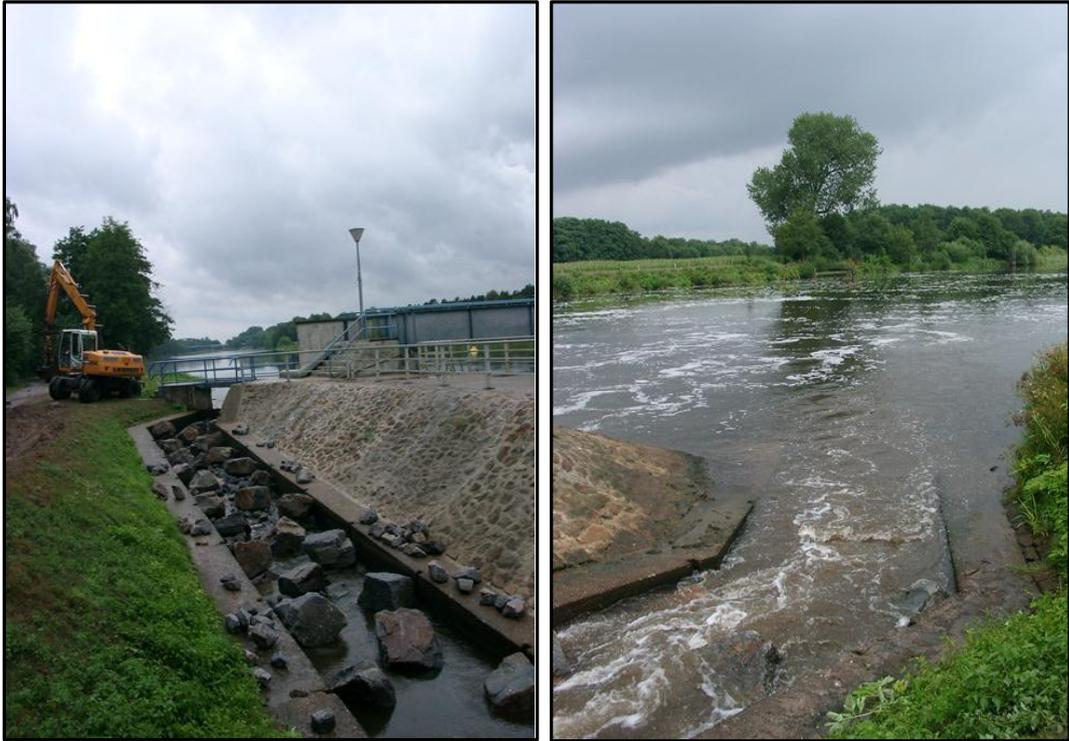
Abbildung 10: Die Fischaufstiegsanlage (FAA) am Wehr Bollingerfähr. Links: FAA während der Ertüchtigung. Rechts: Unterwasserseitiger Anschluss der FAA Bollingerfähr bei mittlerem Emsabfluss (Quelle: jeweils Landesfischereiverband Weser-Ems).
