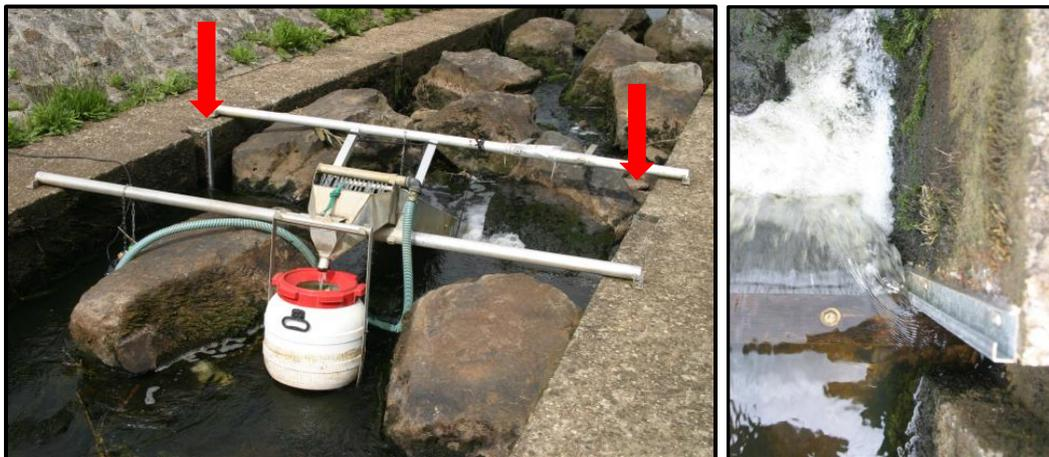
Abbildung 11: Aalleiter in Fangposition mit Auffangbehälter und Wasserversorgung (links). Winkelprofile (rechts) wurden beidseitig auf Höhe des Dammbalkenverschlusses an der Wand der Fischaufstiegsanlage angebracht; die Pfeile im linken Bild zeigen die Positionen der Winkelprofile in der Fischaufstiegsanlage an (Quelle: jeweils Landesfischereiverband Weser-Ems).
