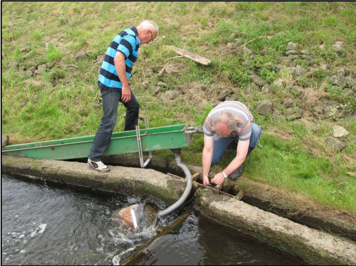
Abbildung 30: Am 28.06. wurde einmalig eine Aalleiter gestellt, die in zukünftigen Untersuchungen ergänzend zu Kescherzügen eingesetzt werden soll. Die Installation ist flutstabil, das heißt, die Aalleiter ist fest montiert und kann vom auflaufenden Wasser überspült werden ohne vorher geborgen werden zu müssen (Quelle: Landesfischereiverband Weser-Ems).
