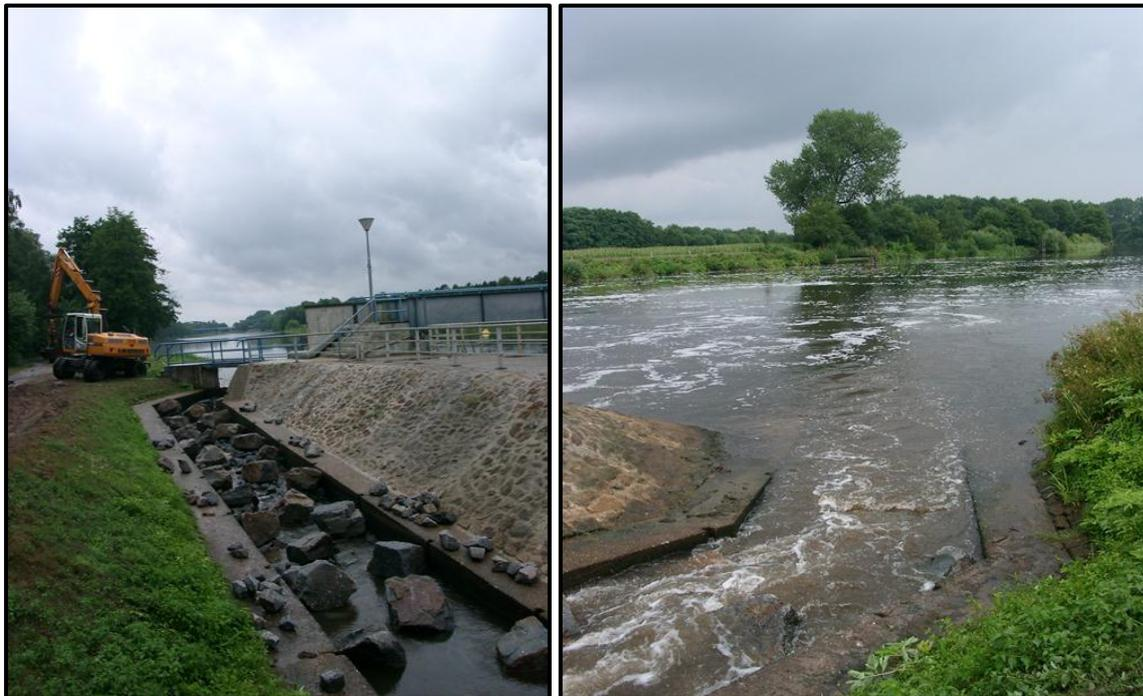
Abbildung 13: Die Fischeaufstiegsanlage (FAA) am Wehr Bollingerfähr. Links: FAA während der
