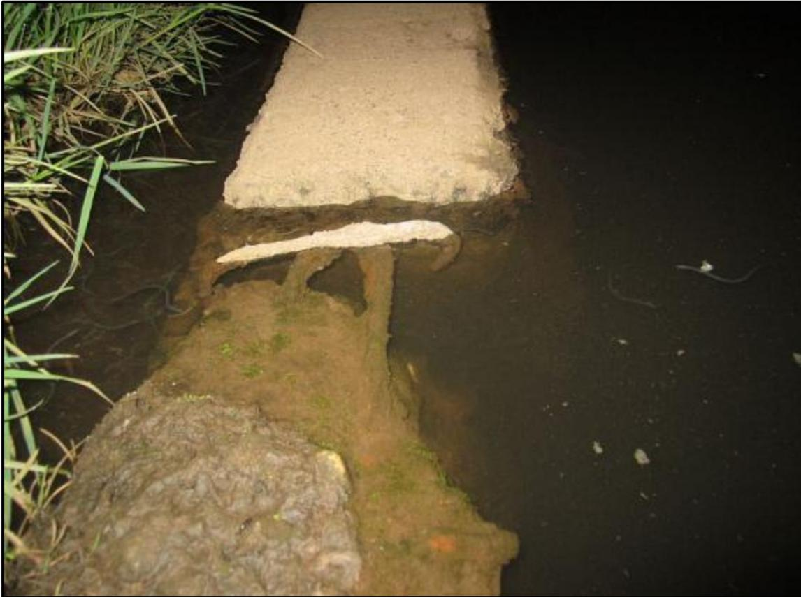
Abbildung 19: Die Betontrennwand zwischen Aalfangrinne (links) und FAA (rechts) ist an einer Stelle kaputt, hier drängen die Glasaale aus der Aalfangrinne in die FAA (Quelle: LAVES).
