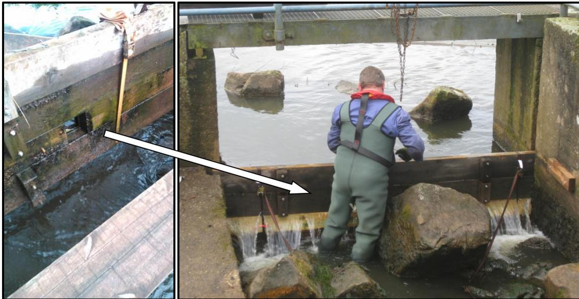
Abbildung 14: Die oberseitige Absperrung des Fischweges (rechts) wurde mit einer Aussparung (links) versehen, die über einen Schieber regelbar war, um die Fischaufstiegsanlage (FAA) flexibel mit mehr Wasser beaufschlagen zu können und damit die Lockwirkung evtl. zu verbessern. Der Pfeil zeigt die Position der Aussparung an (das rechte Bild entstand bereits 2013, also vor Anfertigung der Aussparung) (Quelle: jeweils Landesfischereiverband Weser-Ems).
