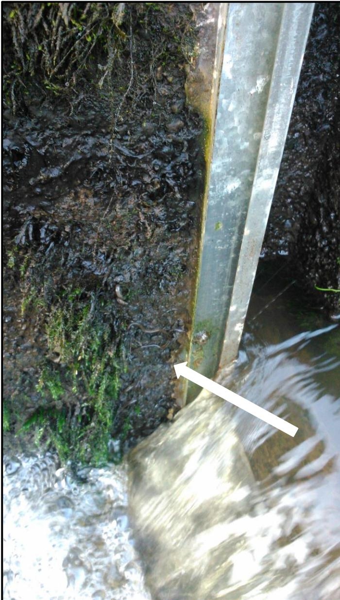
Abbildung 25: Steigaale (Pfeil) erklimmen die Seitenwand der Fischaufstiegsanlage, können jedoch das Winkelprofil nicht überwinden. Damit bleiben sie auf der dem Unterwasser zugewandten Seite des Dammbalkenverschlusses, von der sie nur über die Aalleiter flussaufwärts gelangen können (Quelle: Landesfischereiverband Weser-Ems).
