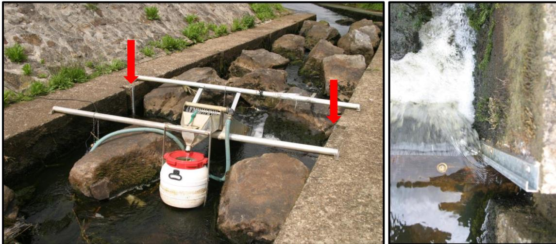
Abbildung 15: Aalleiter in Fangposition mit Auffangbehälter und Wasserversorgung (links). Winkelprofile (rechts) wurden beidseitig auf Höhe des Dammbalkenverschlusses an der Wand der Fischaufstiegsanlage angebracht; die Pfeile im linken Bild zeigen die Positionen der Winkelprofile in der Fischaufstiegsanlage an (Quelle: jeweils Landesfischereiverband Weser-Ems).
