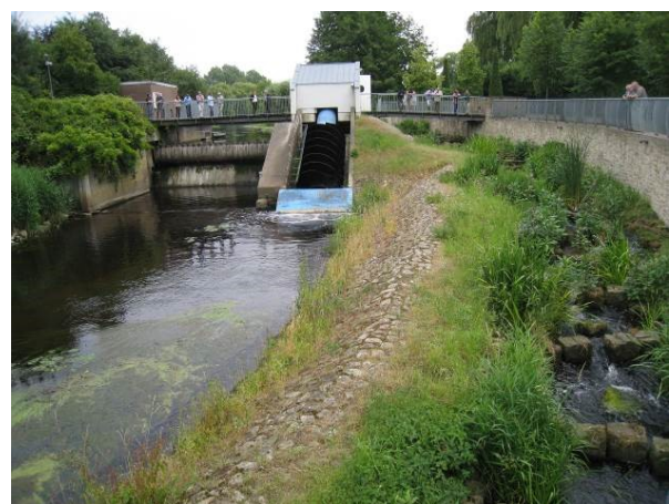
Abbildung 33: Moderne Wasserkraftanlage (Wasserkraft-Schnecke) an der Bocholter Aa in Rhede-Krechting mit Fischaufstiegsanlage am linken Flussufer (Foto: Mosch).
