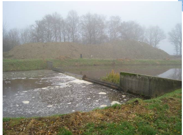
Abbildung 26: Typische Wehranlage, hier in der Rammelbecke, wie sie in vielen kleineren Fließgewässern anzutreffen ist. (Foto: Mosch)
