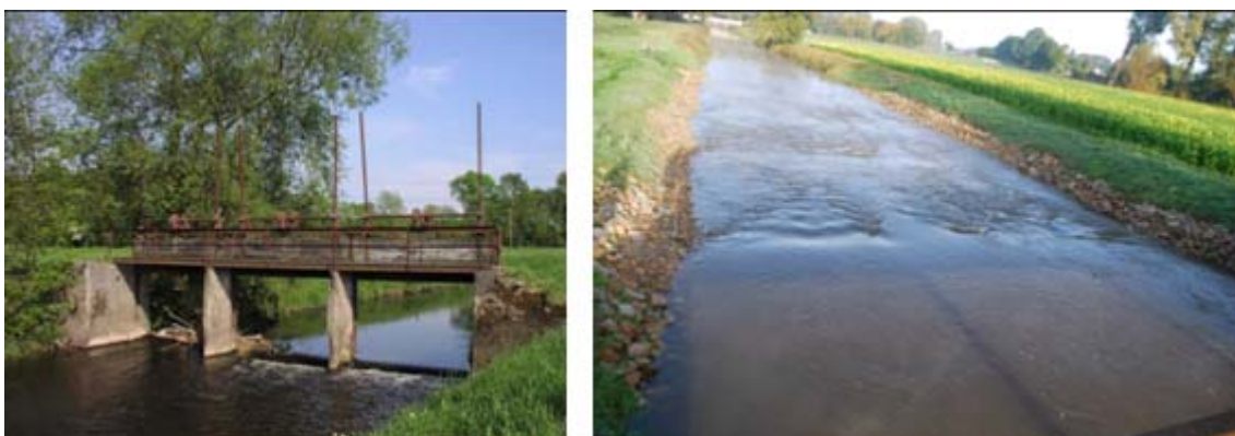
Abbildung 30: Wiederherstellung der Durchgängigkeit durch Umbau einer Kulturstauanlage (linkes Bild) in der Vechte bei Ohne in eine Sohlengleite (rechtes Bild) (aus: Arbeitspapier des NLWKN – Bst. Meppen, „Kulturstau Vechte“).
