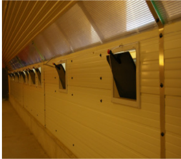
Unterdruck-Lüftung
