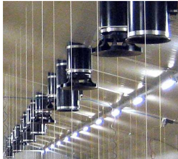
Gleich-/Überdruck-Lüftung
