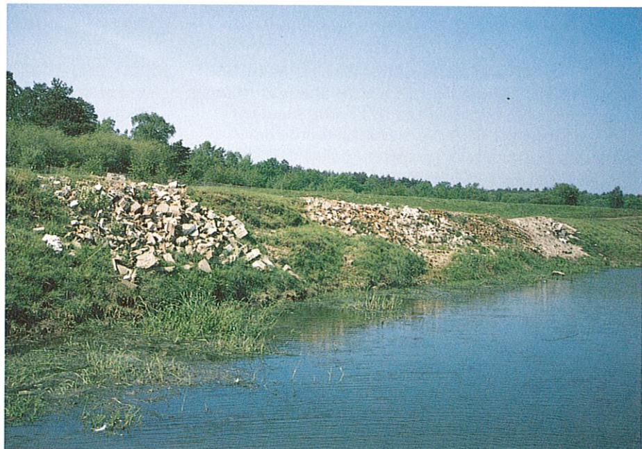
Foto 7: Bauschuttalagerungen am Außenufer des Altarms B
