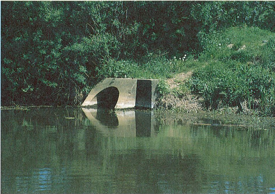
Foto 4: Verrohrung zwischen den beiden Abschnitten des Altarms A
