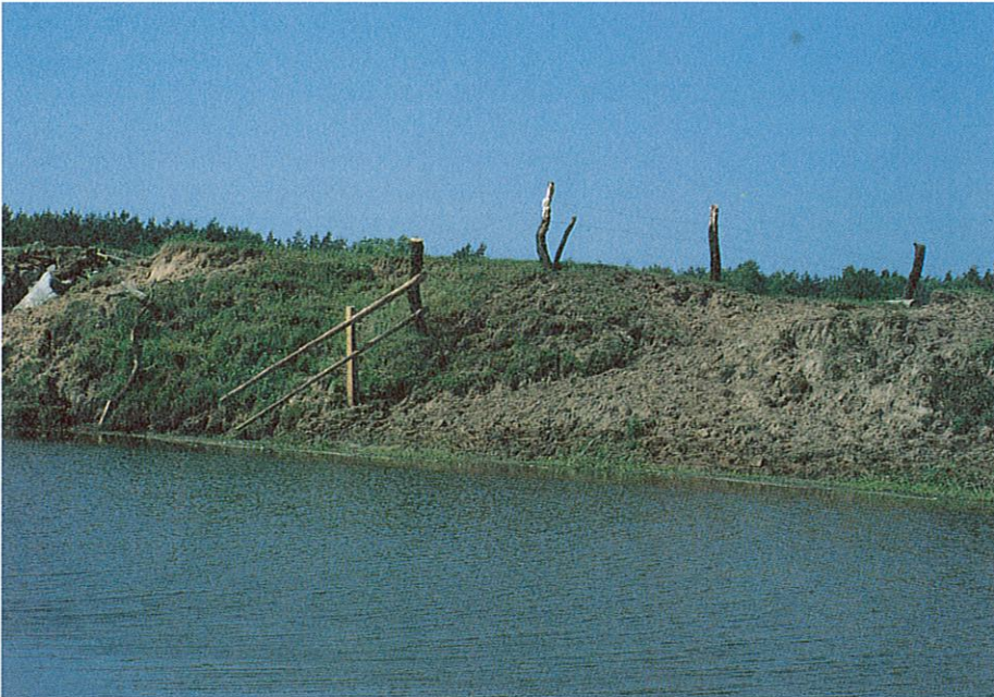
Foto 5: Trittschäden am Außenufer des Altarms B
